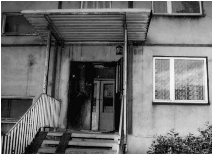
Fot. 03. Wejście do bloku, w którym doszło do zabójstwa
